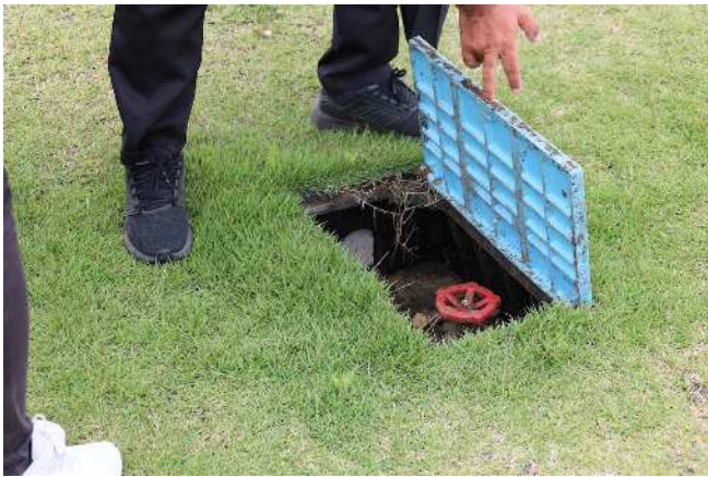
【事後調査】八重瀬町_具志頭運動公園健康増進施設パークゴルフ場
